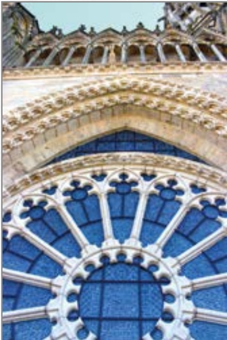
Le travail des tailleurs de pierre sur et autour de la rose, avec l'ajout d'une nouvelle gargouille.
